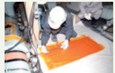
交換作業の様子
